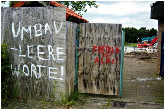
Abriss des Freizeitbades Massen. (Archivbild Rundblick)
