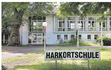
Die ehemalige Harkortschule soll abgerissen werden, sobald das derzeit in ihr untergebrachte Förderzentrum Unna auf den neuen Bildungscampus Königsborn umgezogen ist. Dann wäre die Fläche auch etwas, das durch die Planer von „Bau.Land.Partner“ entwickelt werden könnte.
